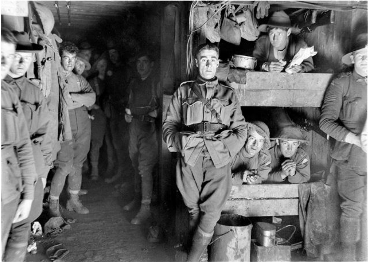
Australische soldaten ingekwartierd in 'Catacombs' tunnel, bij Mesen, 22 januari 1918. [AWM E01509]
