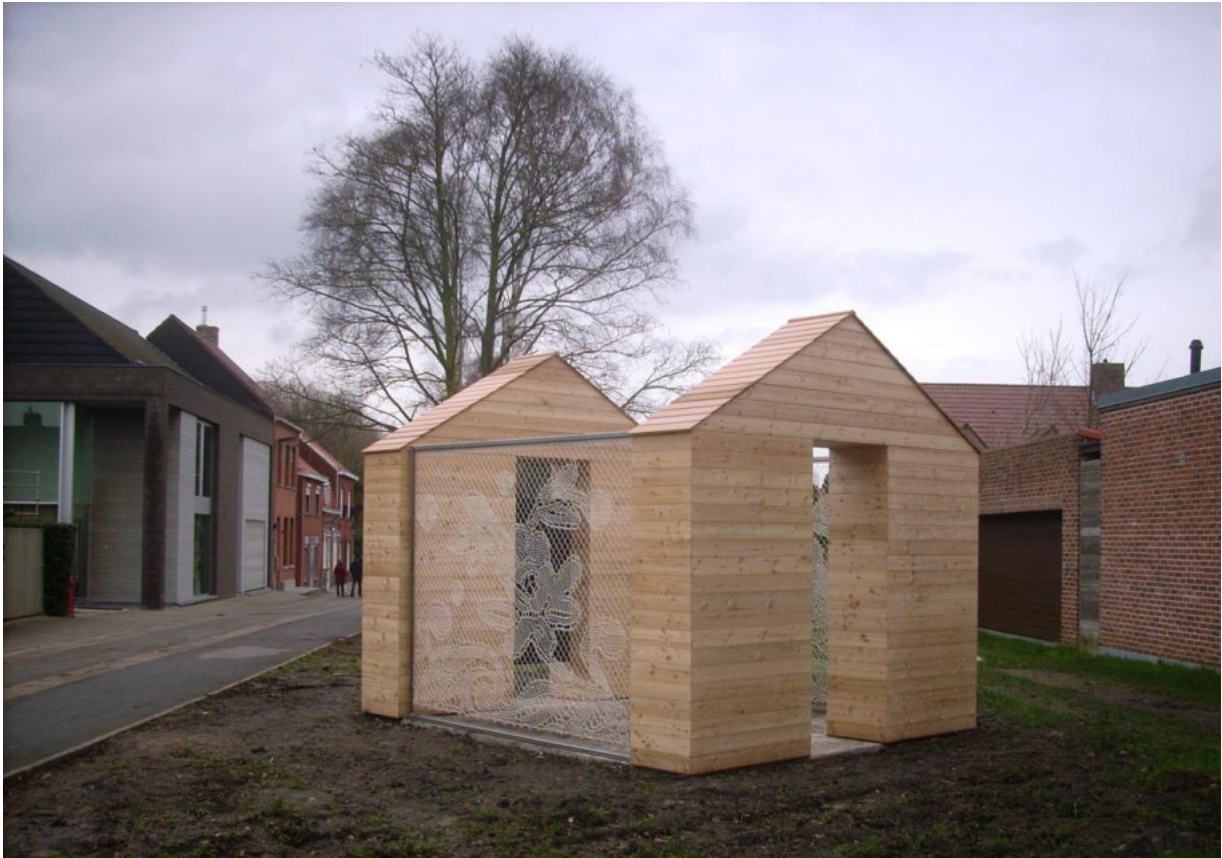
Exilium in aanbouw
